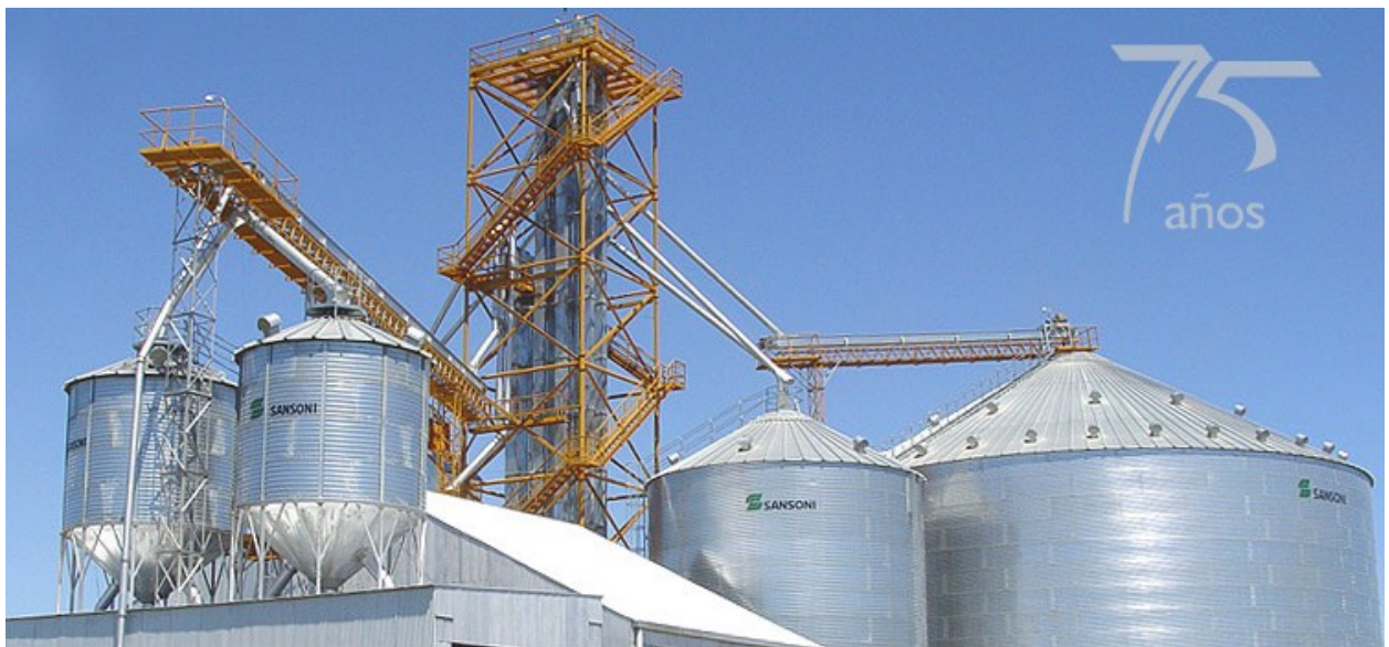
Elevador de Cangilones en Torre de Norias
